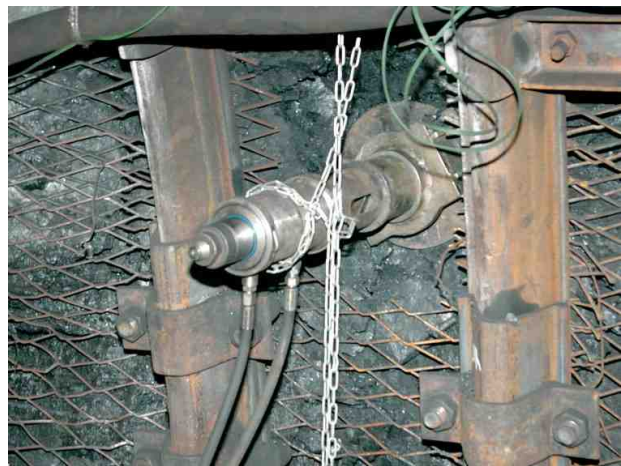
Testování únosnosti svorníků / Testing of rock bolt carrying capacity
