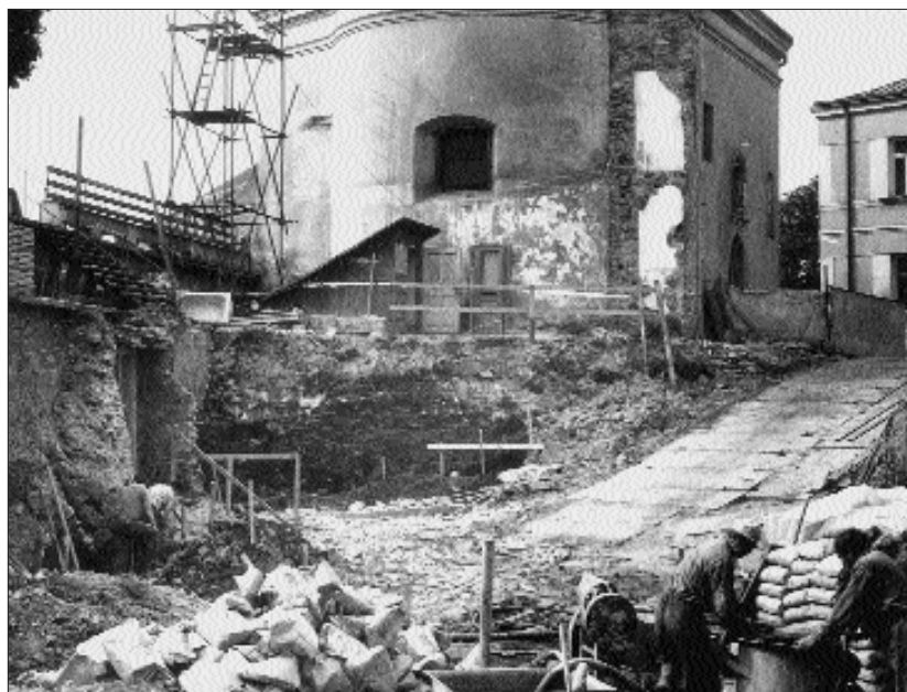
Obr. 3. Přerov, Horní nám. č. p. 8, 9. Pohled od S na stavební jámu, v pozadí zkoumaná plocha A s roštovou hradbou a kaple sv. Jiří.
