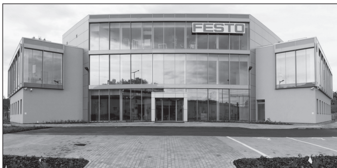
Hlavní průčelí s prosklenou fasádou
