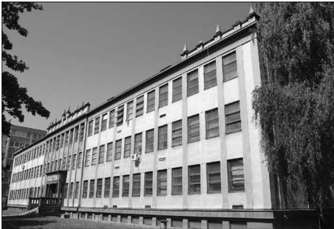
Obr. 2 Foto budovy sídla divize Vývoj z poslední doby
