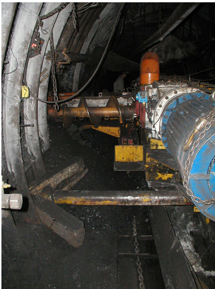
Obr. 3. Odvrtávání komory č. 3 – boční pohled Fig. 3. Drilling of room No. 3 with the drilling machine
