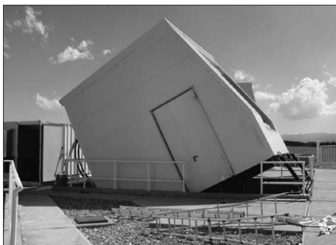
Obr. 4 Fotografie objektu teleskopu v operační poloze
