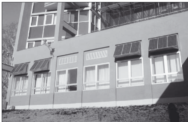
Obr. 1 Umístění demonstračního fotovoltaického systému FVS 2001E na UTB ve Zlíně
