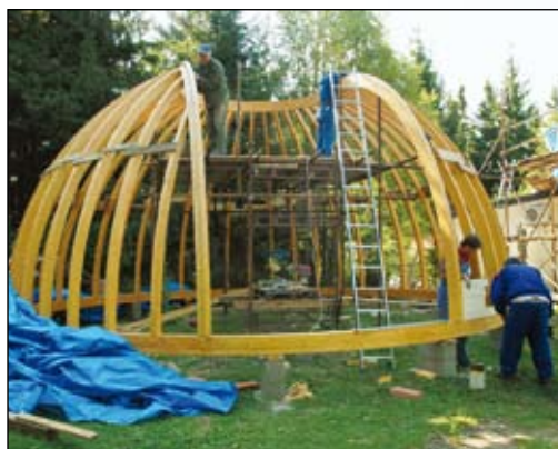
Stavba kopule Klet'
