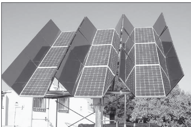
Obr. 3 PV systém se žlabovým koncentrátorem záření
