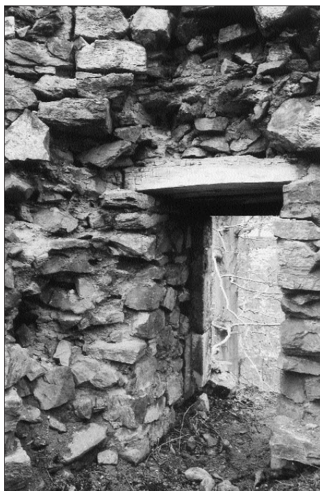
Obr. 19. Rýzmburk, hrad. Detail interiéru věže u brány do jádra hradu. Nika vchodu (srov. obr. 18) je zastropena původními dubovými trámy (dendrochronologické datum 1248/1249). Foto V. Razím 2003. — Abb. 19. Rýzmburk, Burg. Detail des Interieurs des Turmes bei dem Tor in die Kernburg. Die Eingangsnische (vgl. Abb. 18) ist mit den ursprünglichen Eichenramen überdacht (dendrochronologisches Datum 1248/1249). Foto V. Razím 2003.
