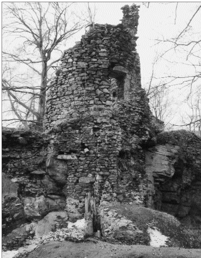
Obr. 18. Ryzmberk, hrad. Válcová věž u brány do jádra hrad, pohled od východu. Nad druhotnou obehzdívkou spodní části věže původní vchod. Foto V. Razím 2003. — Abb. 18. Ryzmberk, Burg. Rundturm beim Tor in die Kernburg, Blick von Osten. Über der sekundären Ummauerung des Unterteiles des Turmes der ursprüngliche Eingang. Foto V. Razím 2003.
