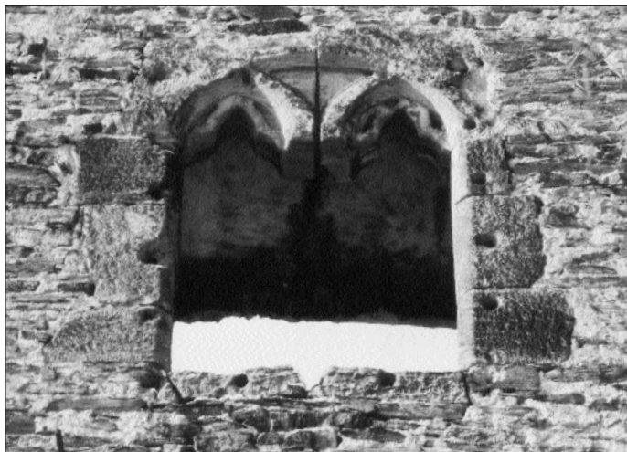
Obr. 4. Říčany, hrad. Detail jednoho z dochovaných sdužených oken v 1. patře raně gotického paláce. Foto V. Razím 2003. — Abb. 4. Říčany, Burg. Detail eines der erhaltenen Kuppelfenster im 1. Stock des frühgotischen Palastes. Foto V. Razím 2003.
