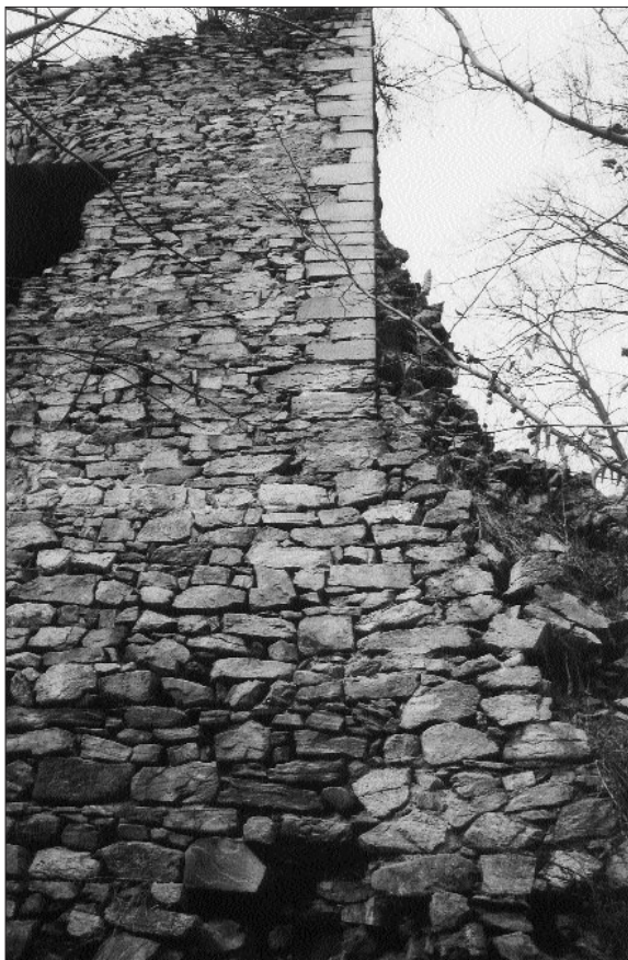
Obr. 14. Ryzmburk, hrad. Detail jižního průčelí jihozápadní nárožní věže jádra hradu, druhotně připojeného k jižní zdi pozdější kaple (dole). Foto V. Razím 2003. — Abb. 14. Ryzmburk, Burg. Detail der Südfront des südwestlichen Eckturmes der Kernburg, die sekundär an die Südmauer der späteren Kapelle angefügt wurde (unten). Foto V. Razím 2003.
