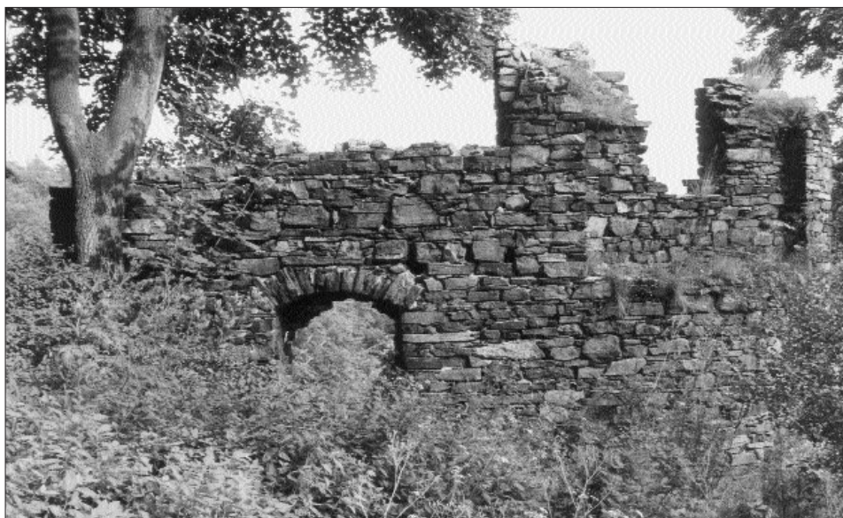
Obr. 10. Rýzmburk, hrad. Vnitřní líc jižní části vnější hradby se sedlovou vížkou (vpravo) a nikou střílny pro palnou zbraň (uprostřed). Srov. obr. 9: 4; 11: A; 12. Foto V. Razím 1994. — Abb. 10. Rýzmburk, Burg. Innenseite des Sütteiles der äußeren Wehrmauer mit Sattelturm (rechts) und Nische der Schiesscharte für Feuerwaffe (inmitten). Vgl. Abb. 9: 4; 11: A; 12. Foto V. Razím 1994.
