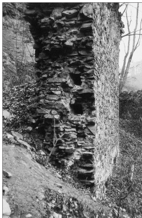
Obr. 20. Rýzmburk, hrad. Zbytky brány v hradební zdi pod východní stranou obytné věže jádra hradu (obr. 9: 15). Dvě kapsy pro zasouvací závoře za zaniklým ostěním, vlevo od nich fragment líce špalety. Foto V. Razím 2003. — Abb. 20. Rýzmburk, Burg. Reste des Tores in der Wehrmauer unterhalb der Ostseite des Wohnturmes der Kernburg (Abb. 9: 15). Zwei Riegellöcher für Schubriegel hinter dem untergegangenen Gewände, links das Fragment einer Leibungsfläche. Foto V. Razím 2003.
