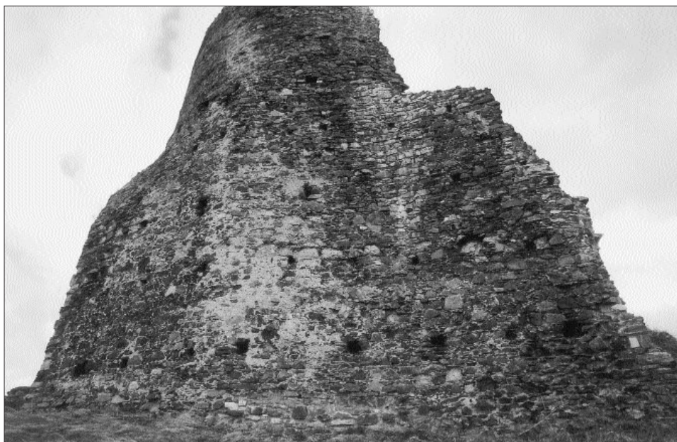
Obr. 26. Lichnice, hrad. Věž v severovýchodním nároží, detailní pohled na severní část vnějšího pláště a navazující hradbu (vpravo) s původními hlubokými otvory po dřevěch lešení a výztuh zdíva (srov. obr. 24 a 25). Foto V. Razím 2004. — Abb. 26. Lichnice, Burg. Turm an der Nordostecke, Detailansicht des Nordteiles des äußeren Mauermantels und der anschließenden Wehrmauer (rechts) mit den ursprünglichen Rüstlöchern (vgl. Abb. 24 und 25). Foto V. Razím 2004.
