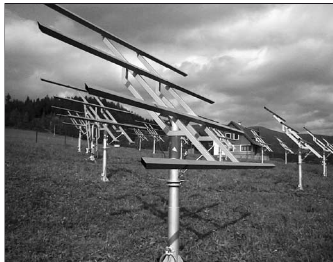
Obr. 3 Pohled na pohyblivé stojany s automatickým sledováním Slunce na pozemku PV elektrárny
