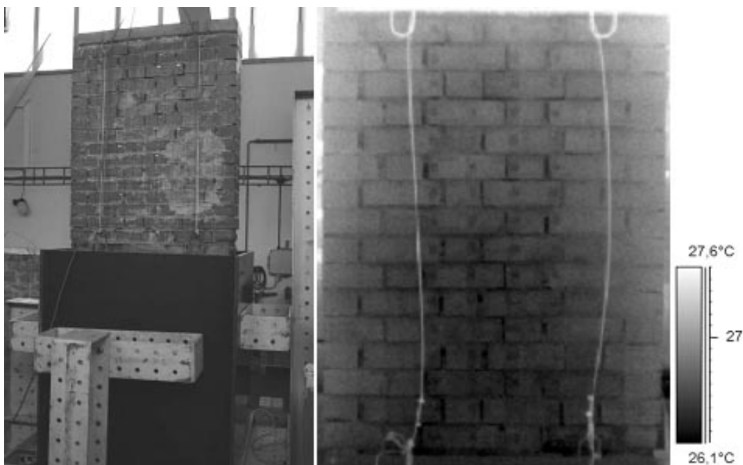
Vysychání historického zdiva: Cihelné zdivo bylo zatopeno vodou po dobu pěti dní (vlevo). Výstup z termokamery (vpravo) ukazuje povrch cihelné zdi po 29 dnech vysychání. Tmavší části jsou ochlazovány vypařováním vlhkosti. Tento efekt lze zaznamenat i takřka po měsíci v běžných laboratorních podmínkách.
