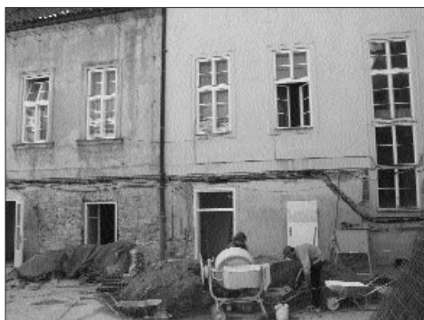
Obr. 1. Rekonstrukce budovy ARÚ AV ČR v Praze, léto 2003.
