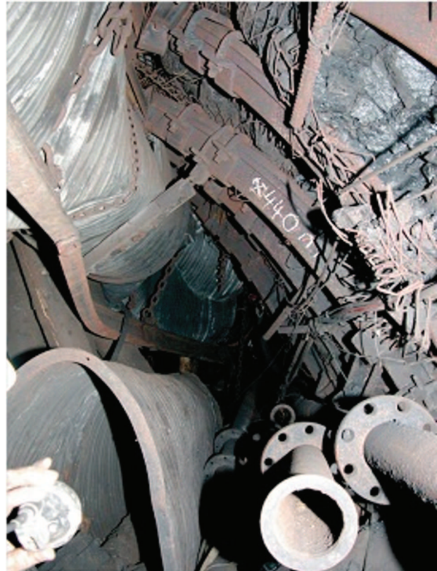
Fotografie devastujícího účinku důlního otřesu / Photo of devastating effect of the rock burst
