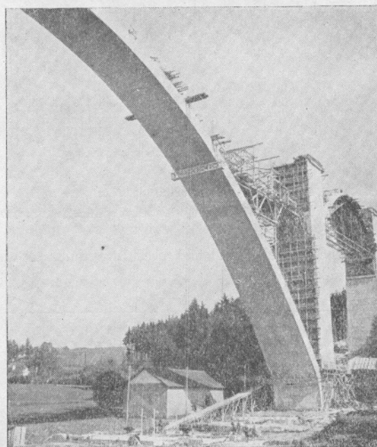
27. Zatěžovací zkouška železobetonového oblouku mostu v Podolsku. 27. Испытания на нагрузку железобетонной арки моста в Подольске. 27. Load test of reinforced concrete arch of the Podolsko bridge.
