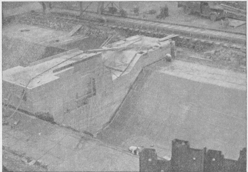
129. Izolace jezové konstrukce měkčeným PVC. 129. Изоляция плотинной конструкции размягченным PVC. 129. Insulating weir structure with softened PVC.
