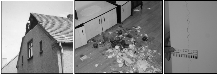
Rys. 1. Przykłady szkód górniczych wywołanych najsilniejszymi wstrząsami w obszarze Górnego Śląska
