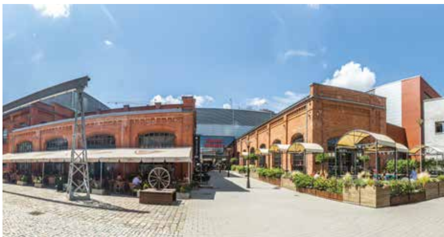
Galerie Vaňkovka se nachází v širším centru města Brna, nedaleko hlavního vlakového nádraží. V roce 1992 se stala kulturní památkou a o dva roky později dokonce vznikla nadace pro záchranu a nové využití areálu. Revitalizace bývalé továrny započala v roce 2000.
