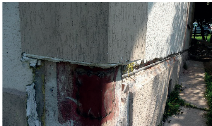
Příklad dodatečného zajištění stavby proti tahovým deformacím pomocí ocelových kotev, které jsou následně zakryty povrchovou úpravou stavby Foto: Eva Jiránková
