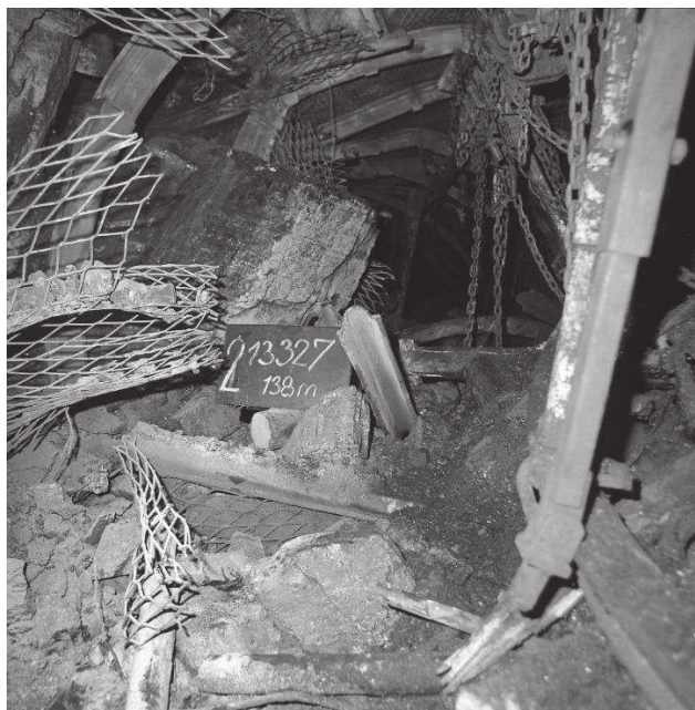
Obr. 11 Následky otřesu horninového masivu v důlní chodbě
