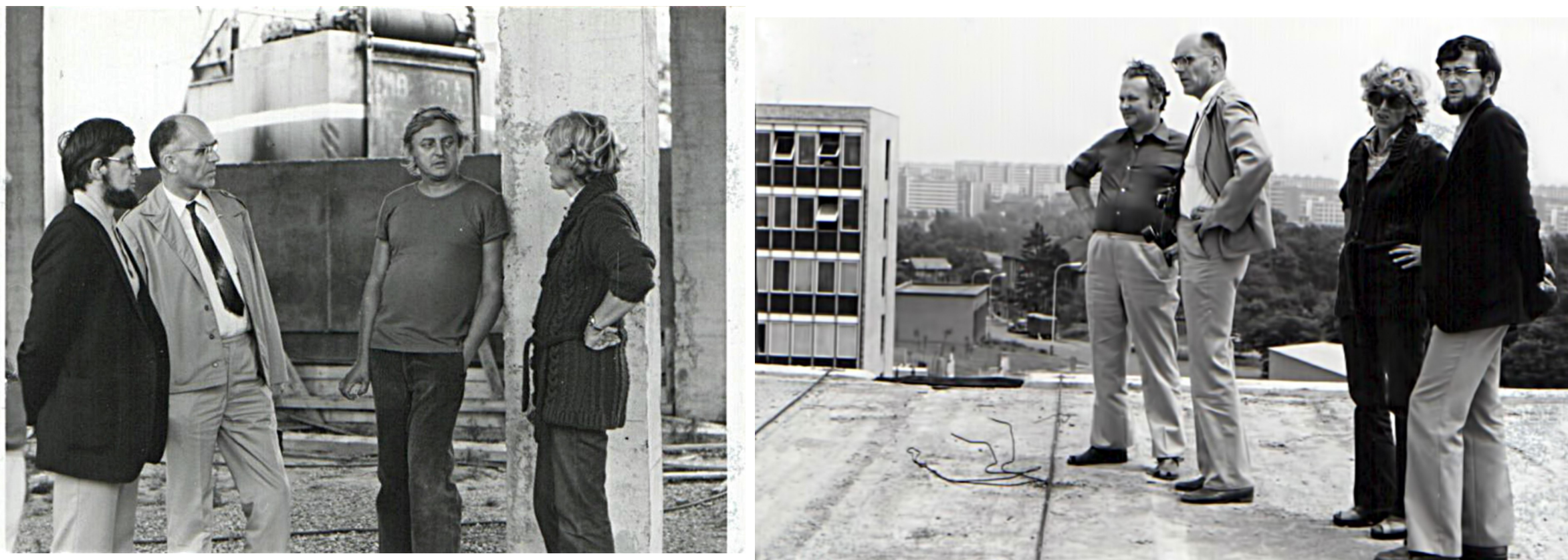
Kontrolní den na stavbě nové budovy ústavu v roce 1981.
