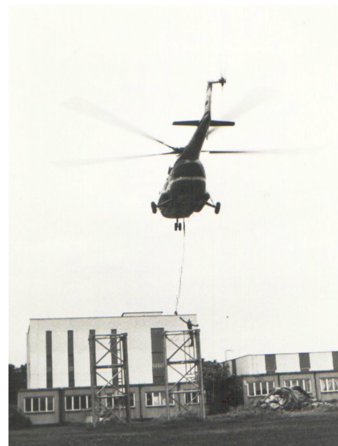
Montáž anténního systému radioreléové trasy mezi SVT a ÚTZCHT v Suchdole v červenci 1985 s pomocí vrtulníku Slovairu.
