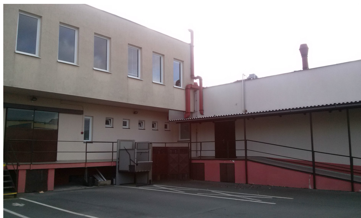
Přístavba ve dvoře Fyzikálního ústavu
