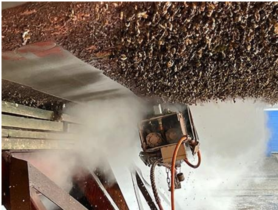
Spodní plocha lodního trupu s patrnými usazeninami. V levé části je vidět původní povrch po očištění stávající technologií rotačního kontinuálního vodního paprsku.
