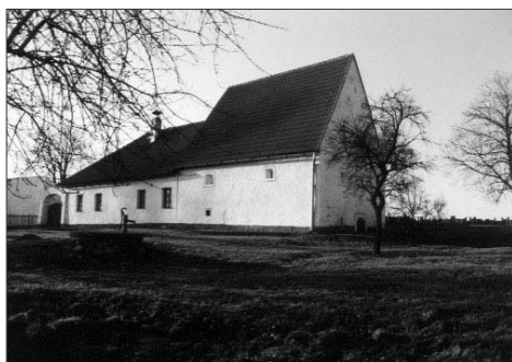
Obr. 3. Opalice čp. 11. Špýcharový dům z 1. poloviny 16. století, pozůstatek usedlosti, pohled od jihovýchodu (foto Ernée 1997). — Abb. 3. Opalice, Haus-Nr. 11 aus der 1. Hälfte des 16. Jh., Reste eines Bauernhofs, Blick von Südosten (Foto Ernée 1997).
