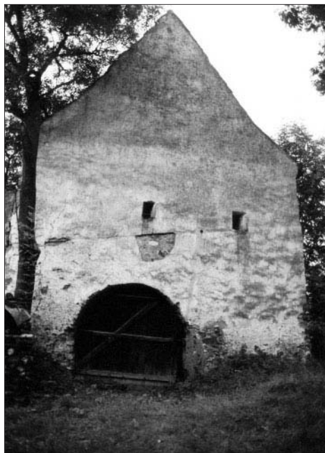
Obr. 7. Opalice čp. 10. Dvoupodlažní kamenný špýchar s vjezdem ve štítové stěně ze 16. století, pozůstatek usedlosti, pohled od západu (foto Ernée 1996). — Abb. 7. Opalice, Haus–Nr. 10. Zweistöckiger Steinspeicher mit Einfahrt an der Giebelseite aus dem 16. Jh., Reste eines Bauernhofes, Blick von Westen (Foto Ernée 1996).
