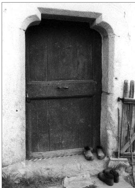
Obr. 16. Krnín čp. 3. Vstupní sedlový portál síně kamenného špýcharového domu (foto Ernée 1996). — Abb. 16. Krnín Haus–Nr. 3. Eingangsportal zum Flur des Hauses (Foto Ernée 1996).
