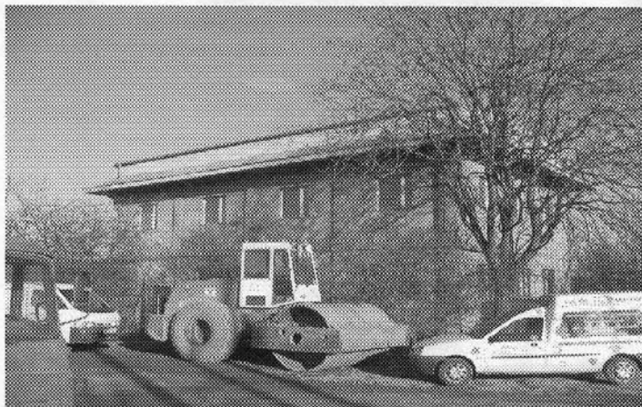
Pohled na budovu z jižní strany
