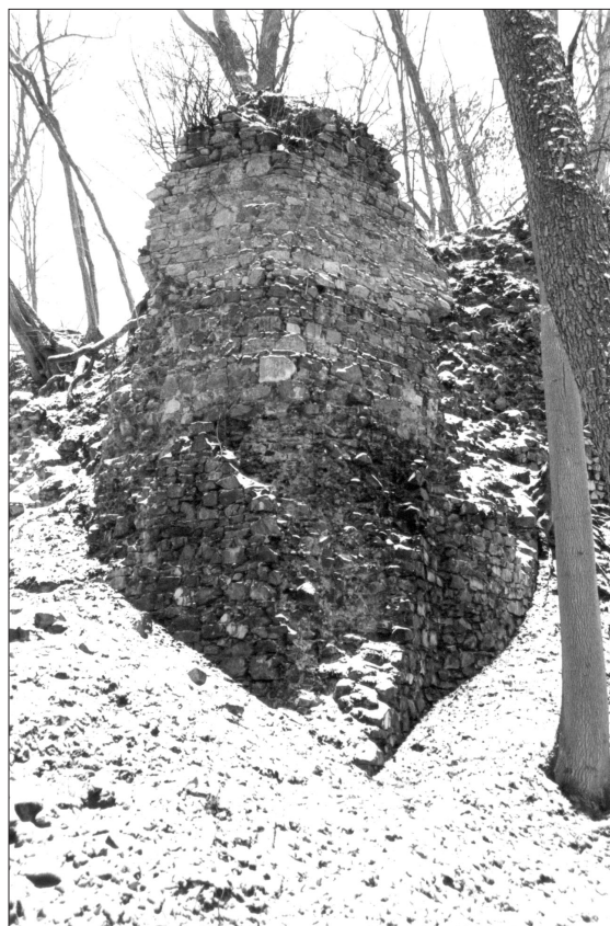
Obr. 27. Týřov, hrad. Pohled od severovýchodu na severovýchodní nárožní věž dolního hradu. V dolní části zbytek původního pláště zdiva, tvořícího pravoúhlý výstupek. V horní části druhotný líc zdiva s odlišným půdorysem a rozdílnou petrografickou skladbou. Foto V. Razím, 2001. — Abb. 27. Burg Týřov. Untere Burg, Nordostansicht des nordöstlichen Eckturms. In der unteren Partie ein die rechtwinklige Ecke bildendes Rest des ursprünglichen Mauermantels. In der oberen Partie sekundäres Mauerhaupt mit abweichendem Grundriss und unterschiedlicher petrographischer Struktur. Foto V. Razím, 2001.
