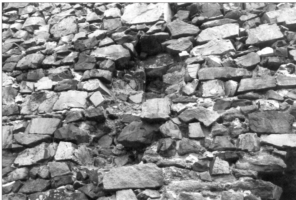
Obr. 20. Týřov, hrad. Detail vnější strany severozápadní zdi věžového paláce horního hradu. Uprostřed původní okénko sklepa. Ostění zaniklo, překlad špalety tvoří opracovaný opukový kámen. Foto M. Micka, 2001. — Abb. 20. Burg Týřov. Obere Burg, Turmpalast, Außenseite der Südwestmauer, Detail. In der Mitte ursprüngliches Kellerfenster. Das Gewände existiert nicht mehr, den Laibungssturz bildet ein bearbeiteter Plänerkalksteinstück. Foto M. Micka, 2001.
