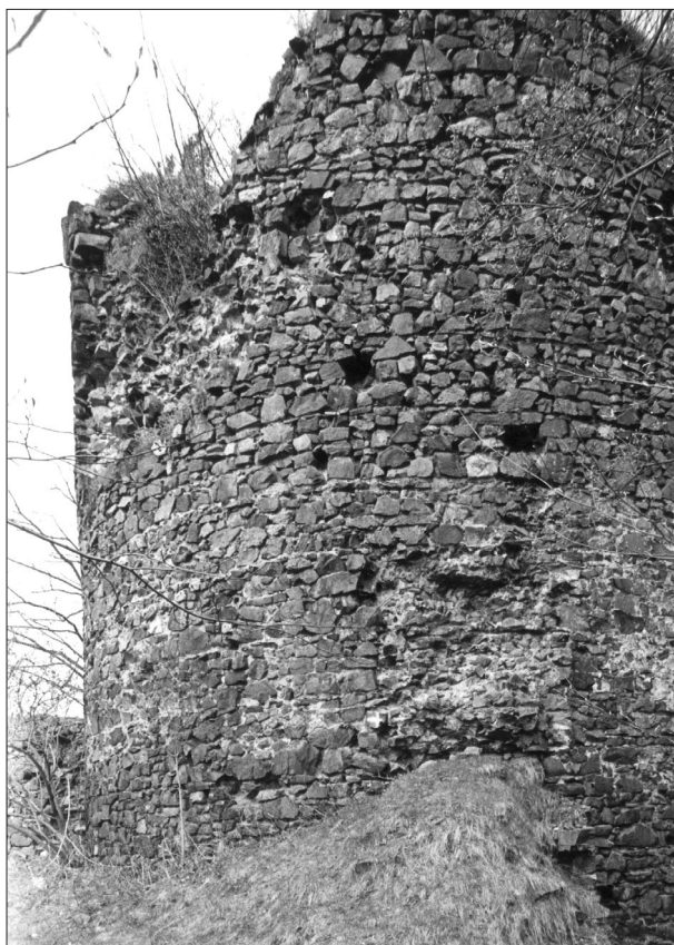
Obr. 6. Týřov, hrad. Pohled od jihu na hlavní válcovou věž (detail). Uprostřed stopa návaznosti hradební zdi s dobře patrnou úrovní ochozu a předprvní zídka. Vlevo nahoře původní vstup do 1. patra věže. Foto V. Razím, 2002. — Abb. 6. Burg Týřov. Südliche Ansicht des Hauptturms (Detail). In der Mitte Spur nach dem Ringmaueranschluß mit der gut deutlichen Umlaufhöhe und Brüstungsmauer. Links oben ursprünglicher Eingang ins erste Stockwerk des Turms. Foto V. Razím, 2002.
