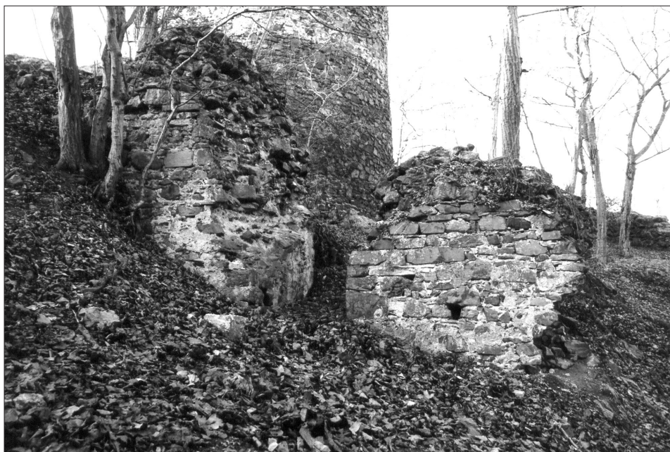
Obr. 13. Týřov, hrad. Pohled od jihovýchodu na zeď příhrádku s prolukou bývalé branky. Vlevo za stromy pod úrovní terénu navazuje severní zeď brány. V pozadí hlavní válcová věž. Foto V. Razím, 2002. — Abb. 13. Týřov, Burg. Südostansicht der Zwingermauer mit der Lücke nach der einstigen Pforte. Links hinter den Bäumen unter dem Geländeniveau Nordmauer des Tors angeschlossen. Im Hintergrund der runde Hauptturm. Foto V. Razím, 2002.
