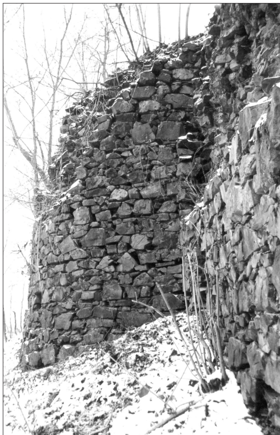
Obr. 24. Týřov, hrad. Pohled od východu na jihozápadní nárožní věž dolního hradu. Líc kurtiny (vpravo) je s pláštěm věže provázaný, na horní části věže však nebyla vazba provedena. Foto V. Razím, 2001. — Abb. 24. Burg Týřov. Südwestlicher Eckturm der unteren Burg, Ansicht von Osten. Das Mauerhaupt der Kurtine (rechts) ist mit dem Turmmantel verbunden, am Oberteil des Turms wurde die Verbindung nicht ausgeführt. Foto V. Razím, 2001.
