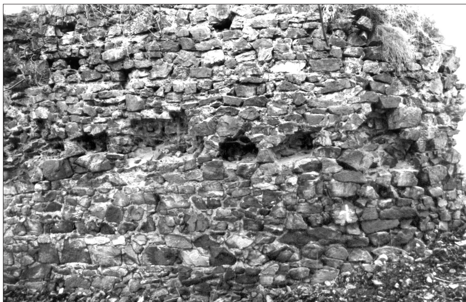
Obr. 12. Týřov, hrad. Pohled na vnitřní líc jižního úseku hradby horního hradu s druhotně vylámanými kapsami pro trámy. Pod kapsami probíhá horizontální petrografické rozhraní. Foto M. Micka, 2001. — Abb. 12. Burg Týřov. Obere Burg, Ansicht der Innenseite des südlichen Ringmauerabschnitts mit sekundär errichteten Balkenlagern. Unter den Balkenlagern deutlicher Verlauf der horizontalen petrographischen Trennung. Foto M. Micka, 2001.
