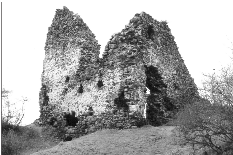
Obr. 15. Týřov, hrad. Pohled od jihovýchodu na věžový palác horního hradu. Vpravo vstup do přízemí, vlevo stopy okenních otvorů přízemí a vchodu do patra. Foto V. Razím, 2002. — Abb. 15. Burg Týřov. Obere Burg, Turmpalaz, Südostansicht. Rechts Eingang ins Erdgeschoß, links Spuren nach den Fensteröffnungen im Erdgeschoß und dem Eingang ins Obergeschoß. Foto V. Razím, 2002.
