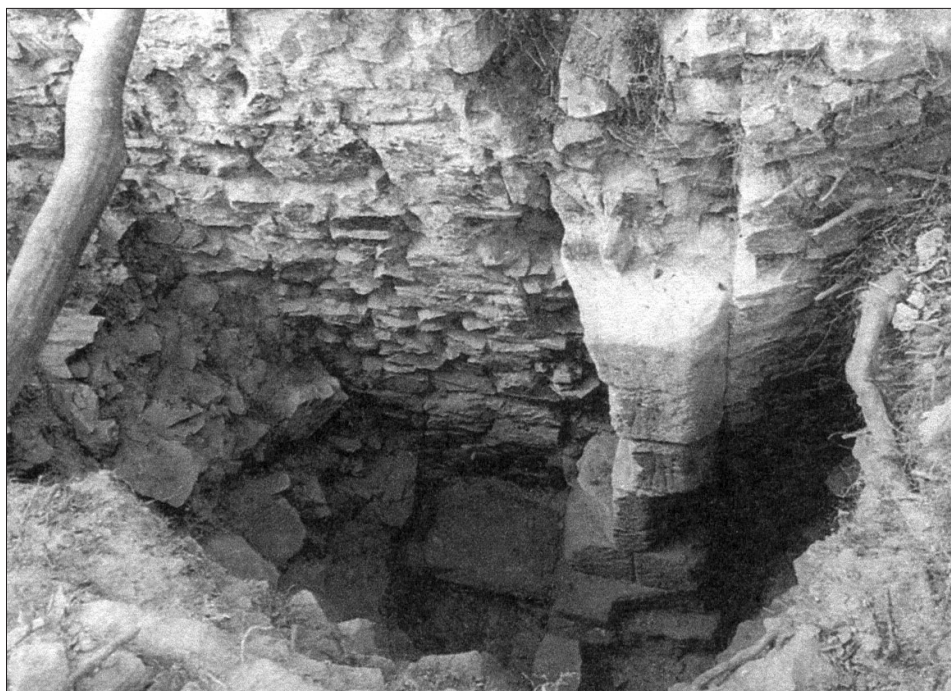
Obr. 14. Týřov, hrad. Pohled do východní části sondy s. IV archeologického výzkumu. Uprostřed zbytek stojky ostění vnějšího portálu brány horního hradu, zřetelně oddělený svislou spárou od zdi příhrádku (vpravo). Převzato z: Durdík 2000 , 11, obr. 2. — Abb. 14. Burg Týřov. Ostteil der archäologischen Sonde s. IV von der archäologischen Grabung. In der Mitte Gewänderest vom äußeren Portal des Tors der oberen Burg, deutlich von der Zwingermauer durch eine vertikale Baufuge getrennt (rechts). Übernommen aus: Durdík 2000 , S. 11, Abb. 2.
