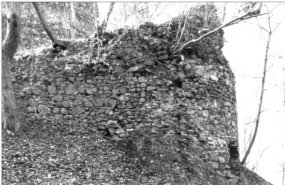
Obr. 25. Týřov, hrad. Pohled od východu na severozápadní věž dolního hradu (vpravo) a zeď příhradku. Uprostřed relikt návaznosti zaniklé kurtiny opevnění dolního hradu. Nad tímto reliktem zbytek oblého pláště věže, k němuž byla zeď příhradku „tečně“ na spáru přiložena. Foto V. Razím, 2001. — Abb. 25. Burg Týřov. Nordwestlicher Turm der unteren Burg (rechts) und die Zwingermauer. In der Mitte ein Relikt nach einem Anschluß der verschwundenen Kurtine von der Befestigung der unteren Burg. Darüber ein Rest vom runden Turmmantel, zu dem sich die Zwingermauer mit einer Baunaht „tangential“ anschloß. Foto V. Razím, 2001.
