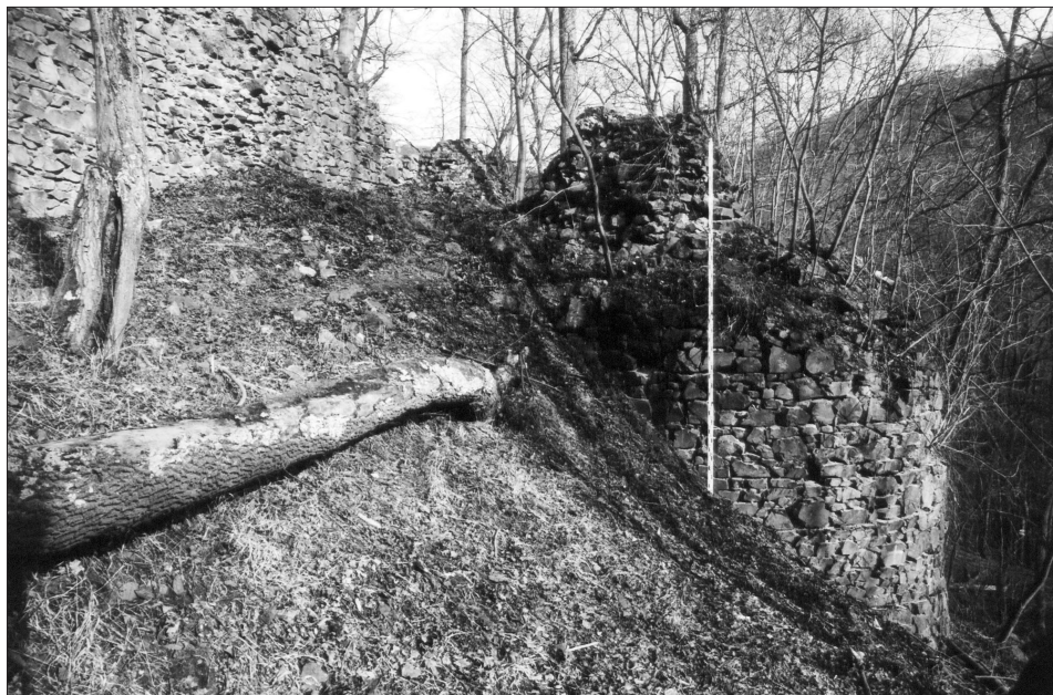
Obr. 23. Týřov, hrad. Jihozápadní nárožní věž dolního hradu v pohledu od západu. Vlevo nahoře jižní zeď horního hradu s reliktem hranolového pilíře (srov. obr. 11). Snímek umožňuje představu o značném výškovém rozdílu mezi základy věže dolního hradu a zdi horního hradu (lať u věže je dlouhá 4 m). Vodorovné technologické spáry zdiva věže dokládají, že výstavba této části opevnění dolního hradu byla zahájena věží a ukončena připojením kurtiny (v nadzemní úrovni zanikla) k pilíři horního hradu. Foto V. Razím, 2002. — Abb. 23. Burg Týřov. Untere Burg, südwestlicher Eckturm, Westansicht. Links oben Südmauer der oberen Burg mit dem Relikt des quadratischen Pfeilers (vergl. Abb. 11). Die Aufnahme vermittelt eine Vorstellung von dem beträchtlichen Höhenunterschied zwischen den Fundamenten des Turms der unteren Burg und der Ringmauer der oberen Burg (die Latta am Turm ist 4 m lang). Horizontale Lagerpalten im Turmmauerwerk beweisen, daß der Ausbau dieses Teils der Befestigung der unteren Burg mit dem Turmbau begonnen hatte und mit dem Anschluß der (in überirdischen Teilen verschwundenen) Ringmauer an den Pfeiler der oberen Burg abgeschlossen wurde. Foto V. Razím, 2002.
