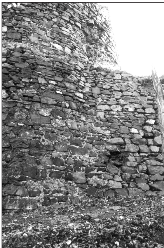
Obr. 8. Týřov, hrad. Detail návaznosti hlavní válcové věže na vnější líc severního úseku hradební zdi horního hradu. Zejména v dolní partii byl plášť zdiva věže připraven pro navázání hradby. Zdivo věže má oproti hradební zdi odlišnou petrografickou skladbu, maltu i výškovou úroveň horizontálních technologických spár. Foto V. Razím, 2001. — Abb. 8. Burg Týřov. Obere Burg, Anschlußdetail zwischen dem Hauptturm und der Außenseite des nördlichen Abschnitts der Ringmauer. Besonders in der unteren Partie wurde der Turmmantel zum Anschluß der Ringmauer vorbereitet. Das Turmmauerwerk besitzt im Unterschied zu jenem der Ringmauer unterschiedliche petrographische Struktur, Mörtel und Höhe der horizontalen Lagerspalten. Foto V. Razím, 2001.
