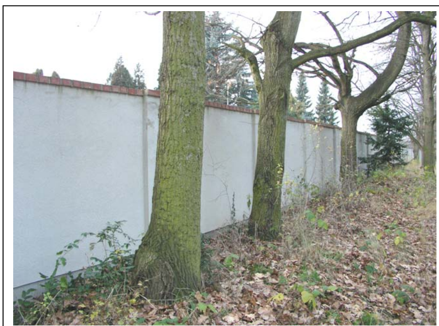
Ukázka opraveného úseku ohradní zdi parku
