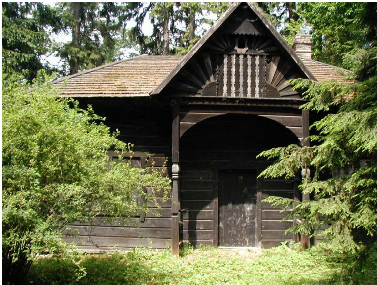
Objekt „Rybárna“, pohled z jižní strany
