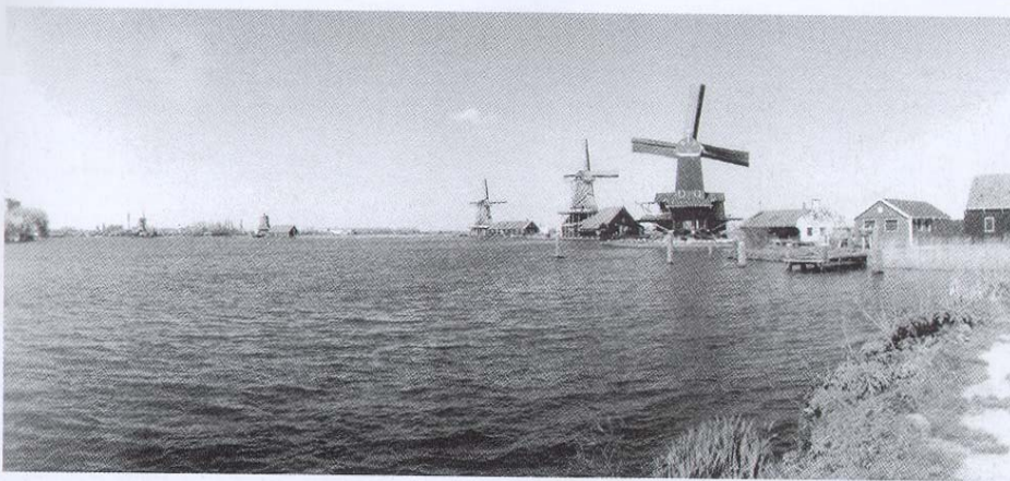
Původní poldry musely být nepřetržitě odvodňovány čerpáním vod větrnými mlýny: skutečný triumf paleotechnického inženýrství, chráněný jako kulturní památka. Dnes se čerpání vod provádí elektricky a zbylé větrné mlýny se udržují jako záloha pro případ nouze a jako turistická atrakce. Kinderdijk, Nizozemsko.
