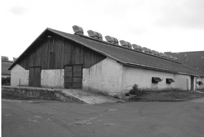
Obr. 1 Skutečná vnější a vnitřní dispozice haly v Červeném Újezdě. Za pozornost stojí průduchy ve stropě drůbežárny, které jsou opatřeny posuvnými zástěny, jimiž v praxi obsluha reguluje intenzitu odvodu vzduchu z prostoru.
