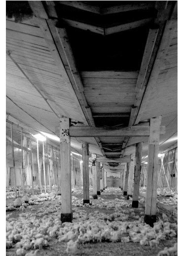
Obr. 1 Skutečná vnější a vnitřní dispozice haly v Červeném Újezdě. Za pozornost stojí průduchy ve stropě drůbežárny, které jsou opatřeny posuvnými zástěny, jimiž v praxi obsluha reguluje intenzitu odvodu vzduchu z prostoru.
