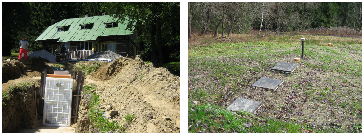
Instalace septiku na Dolních Mísečkách
