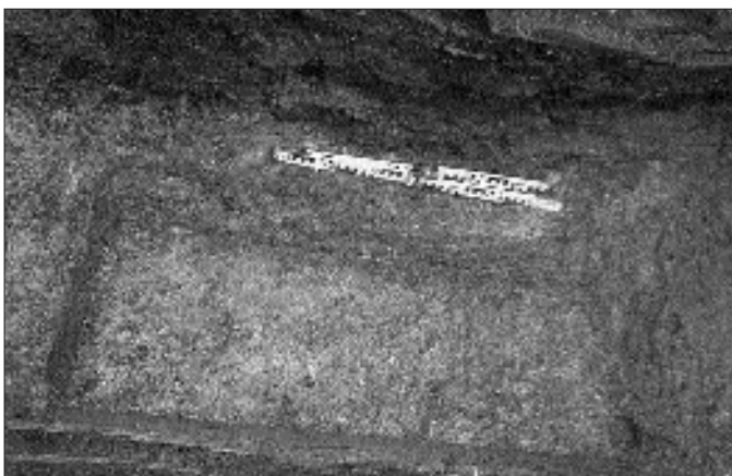
Obr. 5. Čáslav, objekt 1513. Prostor výkopu pro vodovodní potrubí s začištěným schodem a prahem zahloubeného pravouhelného objektu (foto M. Tomášek). – Fig. 5. Čáslav, feature 1513. The excavation space for water mains, with the cleaned step and lintel of a sunken, right-angled feature.
