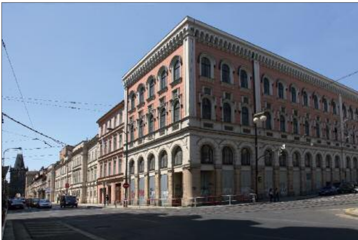
Lannův palác na rohu Hybernské a Havlíčkovy ulice v Praze 1
