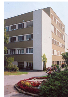
budova ÚEB v Rozvojové ulici v Praze
