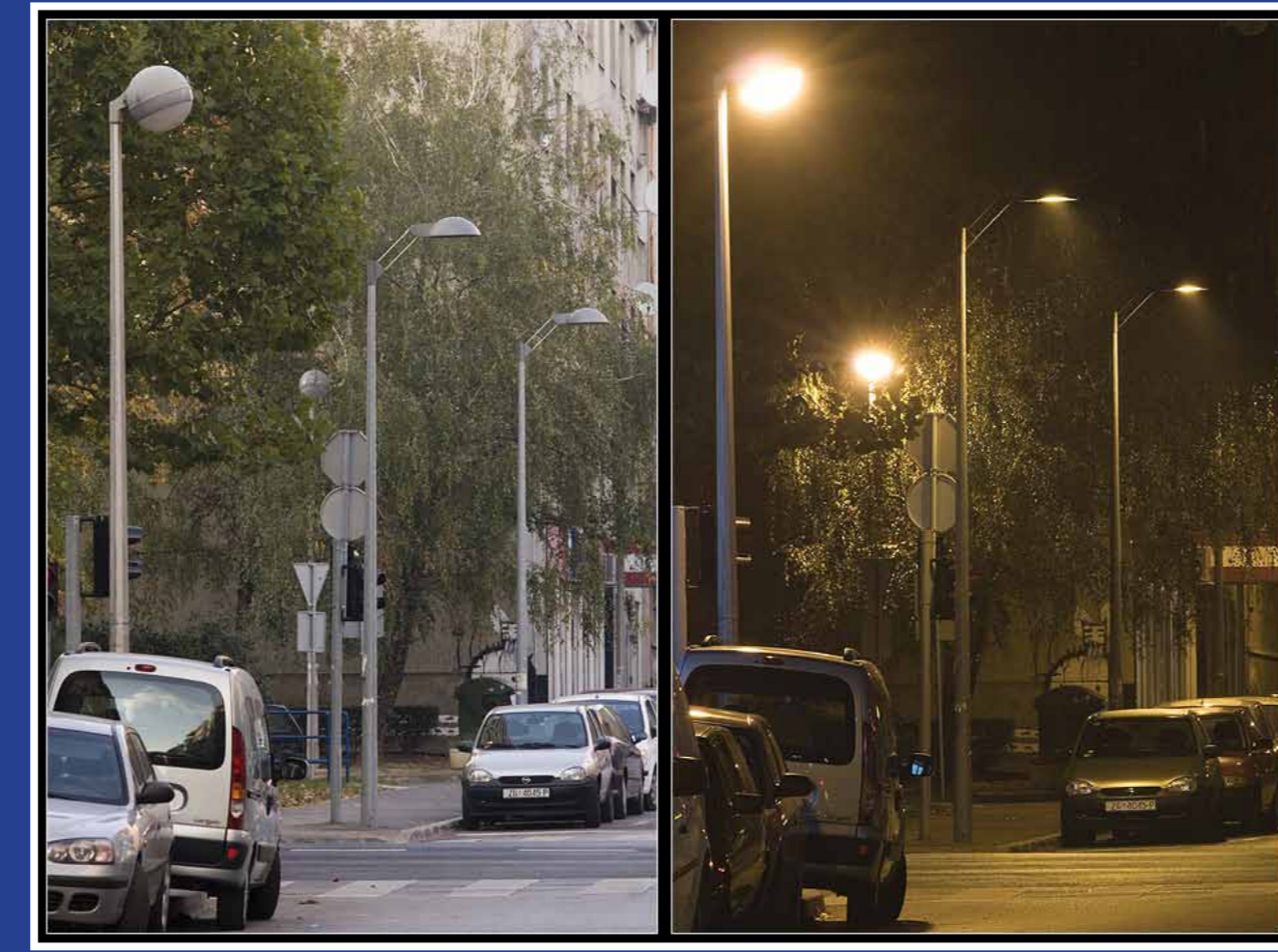
Praktické srovnání vhodného typu veřejného osvětlení (lampa v pozadí), které osvětluje pouze určený prostor a naprosto nevhodného VO se zbytečným parazitním světlem šířeným všemi směry... Foto Dark Sky Slovenia
