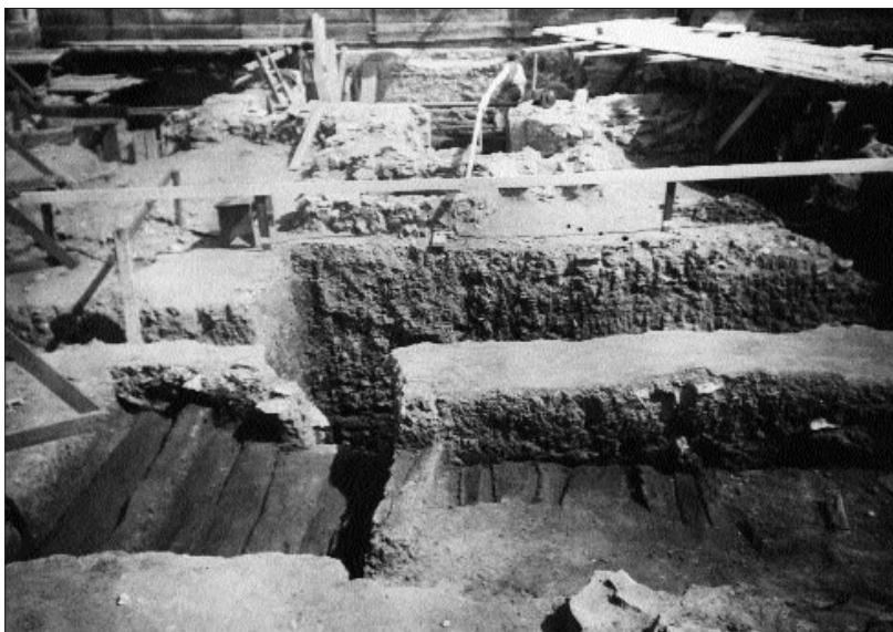
FOTO 5. PRAHA – HRAD, III. NÁDVŮŘÍ. DETAIL ROSTOVÉ KONSTRUKCE STARŠÍ DŘEVOHLINĚ HRADBY. VÝZKUM 1927. FOTO ARCHIV ARÚ. – PRAGER BURG, III. BURGHOF. DETAIL EINER ROSTKONSTRUKTION DER ÄLTEREN HOLZ-ERDE-MAUER. GRABUNG 1927. FOTO ARCHIV ARÚ.
