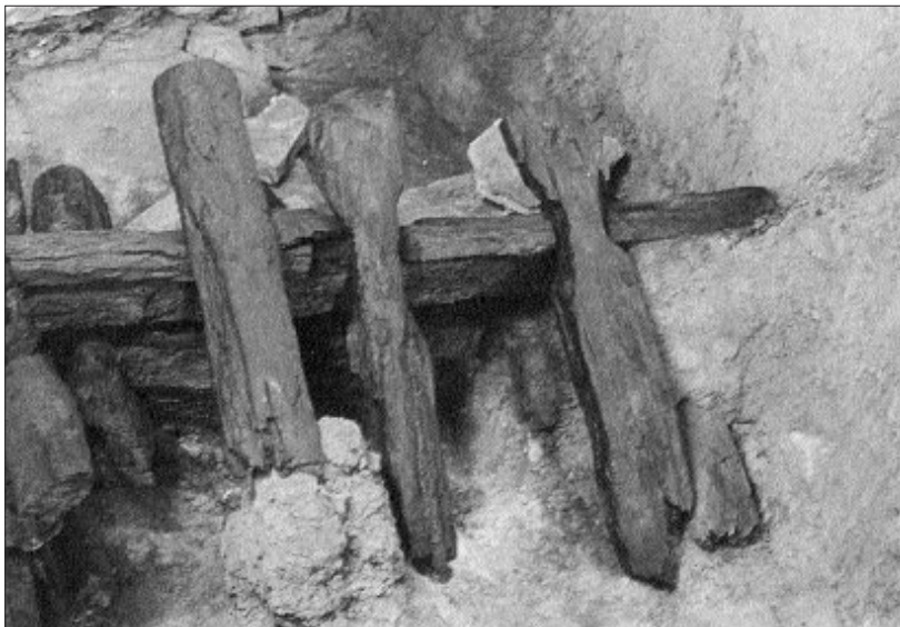
FOTO 9. PRAHA – HRAD, III. NÁDVORÍ. DŘEVĚNÁ VÝZTUŽ MLADŠÍ FÁZE DŘEVOHLINITÉ HRADBY. VÝZKUM 1927, STAV 1998. FOTO I. BOHÁČOVÁ. – PRAGER BURG, III. BURGHOF. HOLZKONSTRUKTION DER JÜNGEREN PHASE DER HOLZ-ERDE-MAUER. GRABUNG 1927, STAND 1998. FOTO I. BOHÁČOVÁ.
