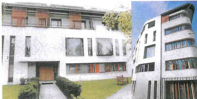
» Pražská Villa Bianca (italsky »bílá«) je příkladem, jak může nově vyvinutý fotokatalytický nátěr vylepšit fasádu domu
