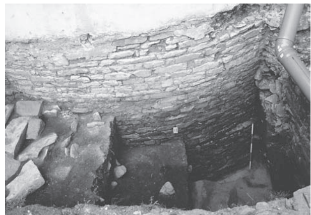
Abb. 5. Stará Boleslav 2003. Mauerwerk der Südapsis. Foto I. Boháčová.
