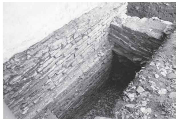
Abb. 4. Stará Boleslav 1997. Mauerwerk der NO-Ecke der Vrábská-Kapelle mit angefügter Einfriedungsmauer. Blick vom SO. Foto I. Boháčová.
