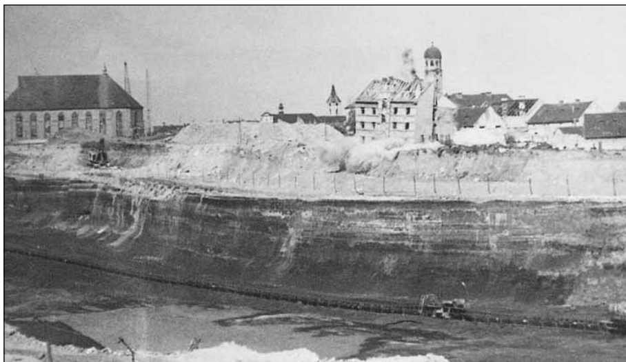
Odstřel budovy technických služeb v Mostě v roce 1974, vlevo kostel Nanebevzetí Panny Marie (foto ze sbírky Státního okresního archivu Most)
