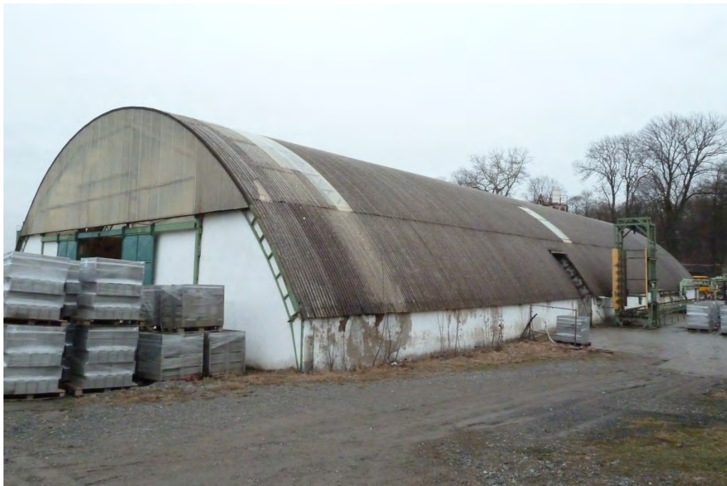
19. Jižní fasáda a západní štít obloukové haly
