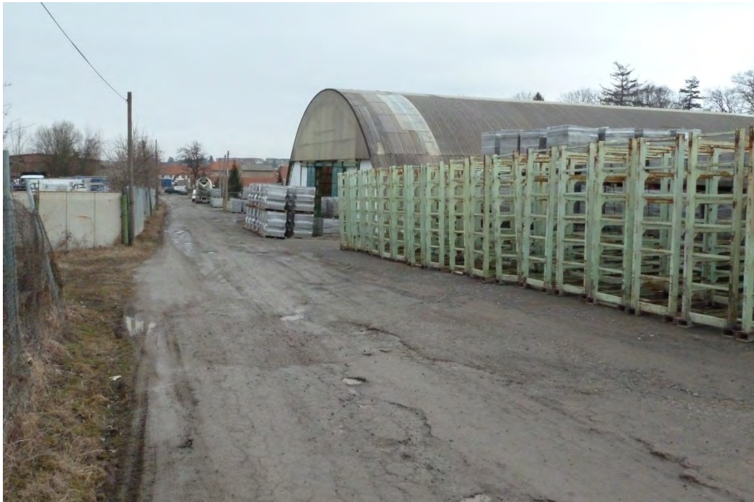
13. Vnitroareálová komunikace podél západní hranice areálu
