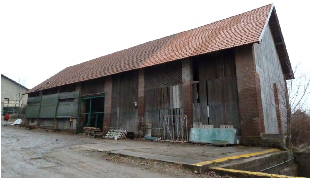
35. Stávající objekt využívaný jako sklad
