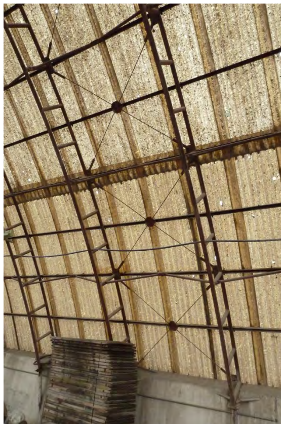
31. Vazníková konstrukce zastřešení obloukové haly
