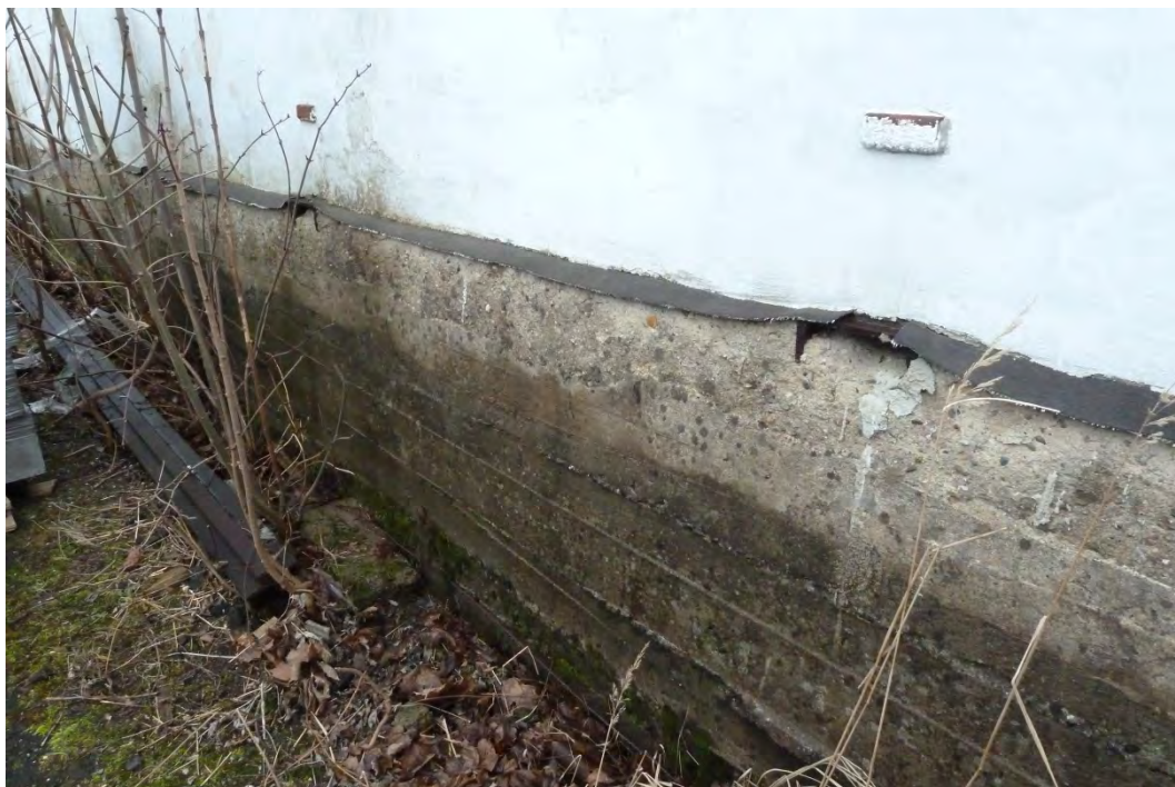
22. Detail ukončení vodorovné hydroizolace pod obvodovou podezdívkou
