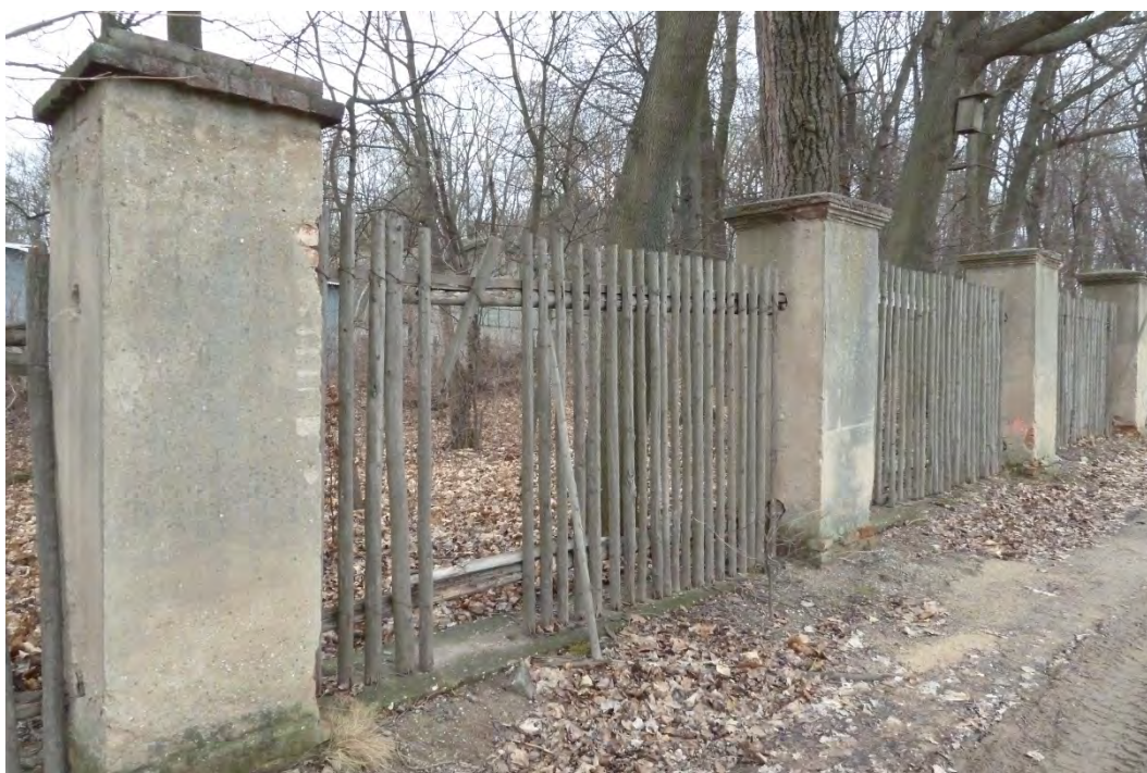
6. Oplocení podél východní hranice areálu
