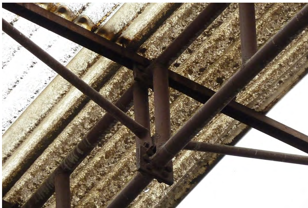
32. Detail šroubového styku střešního vazníku
