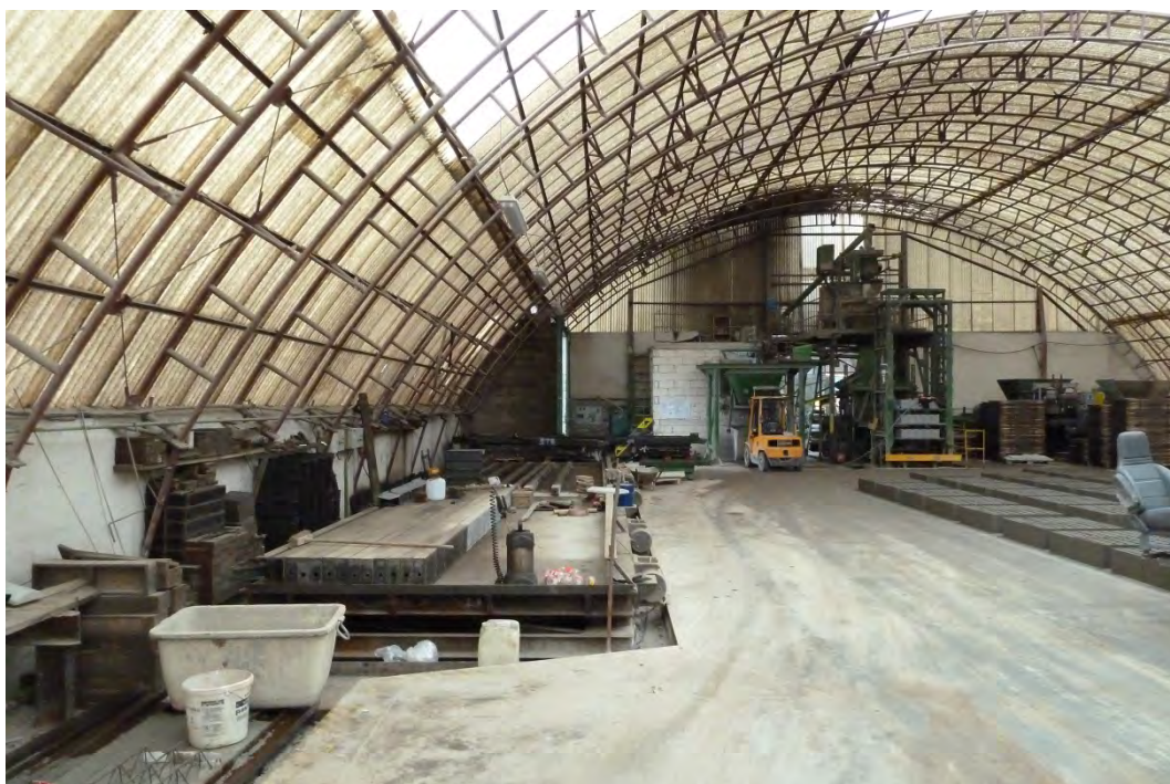
25. Snížená úroveň podlahy podél severní fasády obloukové haly
