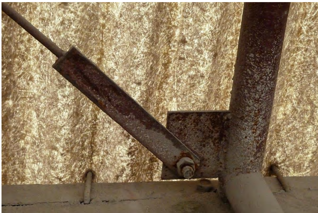
34. Detail napojení zavětrovacího prutu na střešní vazník
