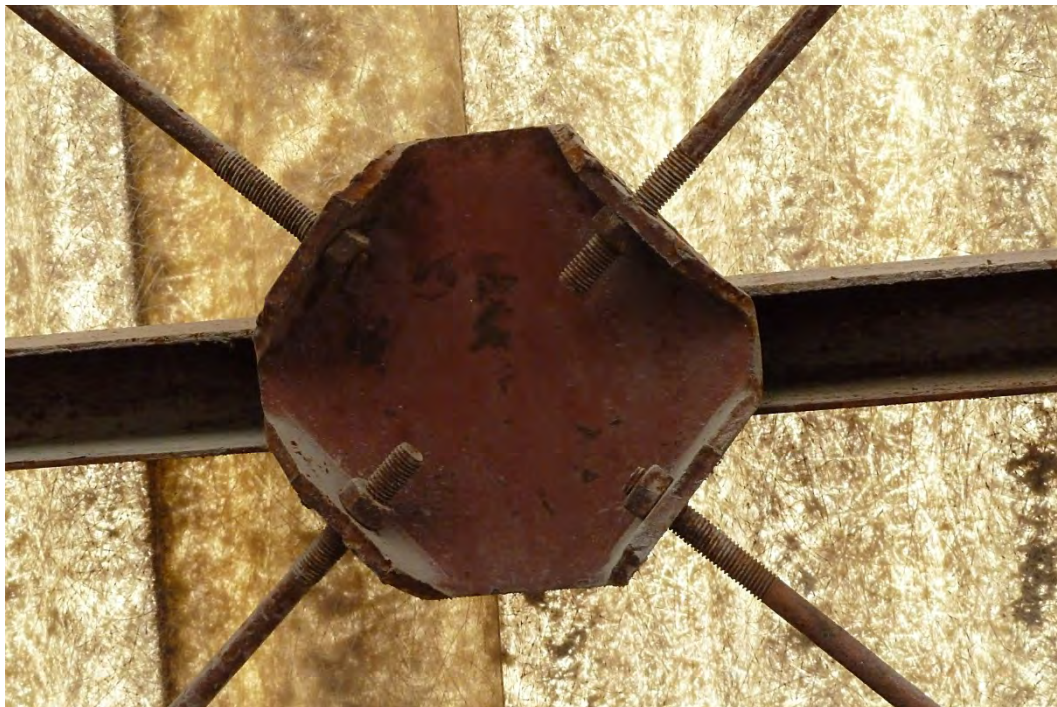
33. Detail středového styku zavětrovacích prutů
