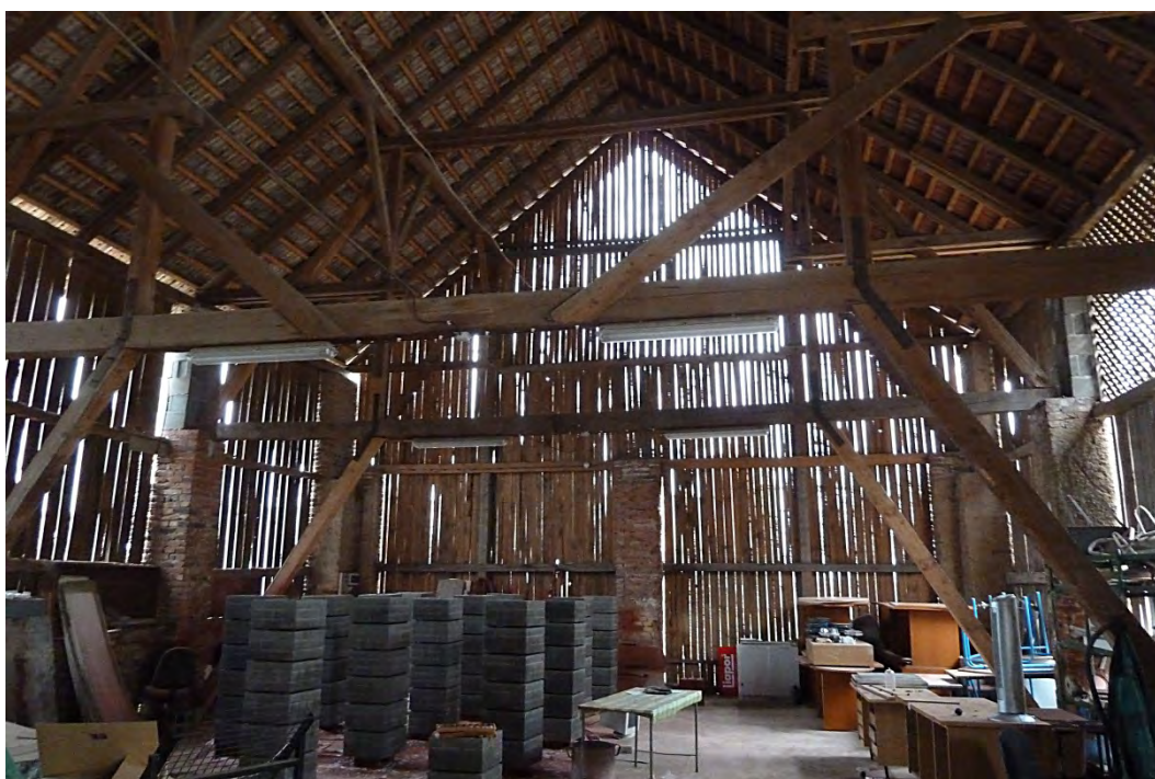
36. Interiér objektu využívaného jako sklad
