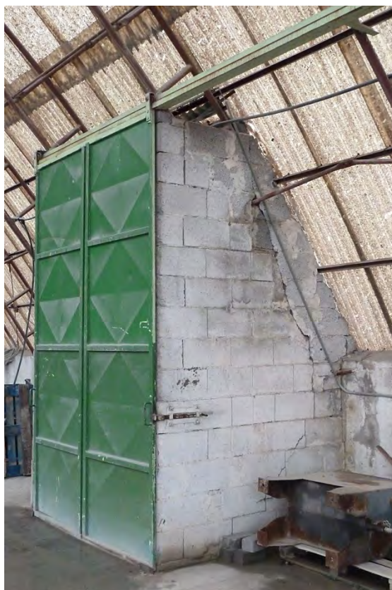
28. Boční vstup do obloukové haly z jižní strany
