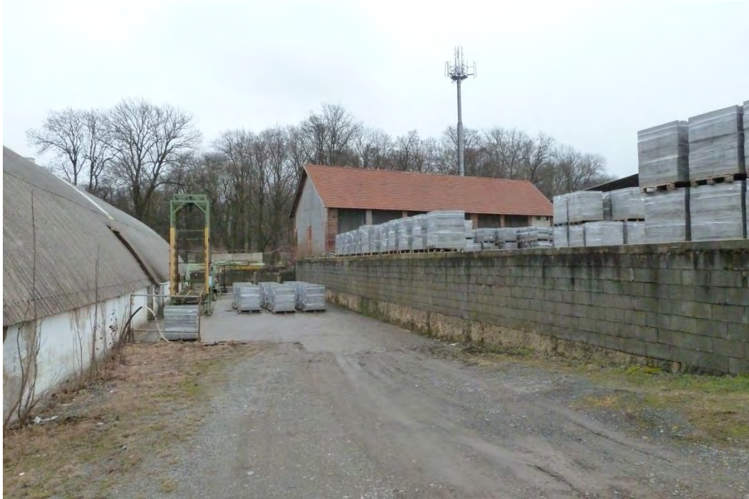
15. Volná plocha vedle jižní fasády obloukové haly
