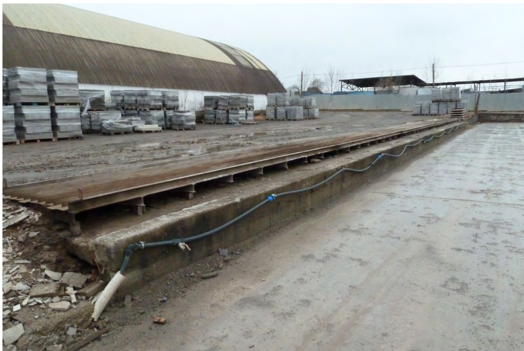
12. Výškový stupeň mezi 2 úrovněmi volné plochy severně od obloukové haly
