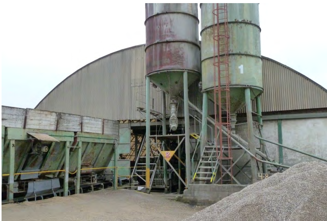
18. Sila na výrobu betonové směsi - východní fasáda obloukové haly
