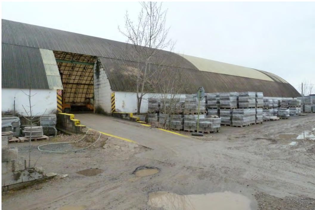
11. Boční vjezd do haly - severní fasáda
