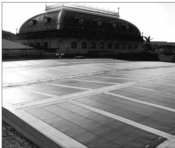
Optimální způsob pro fotovoltaické systémy jsou střešní instalace. Snímek z hospodářské budovy Národního divadla v Praze ukazuje příklad využití její střechy. Foto: B. Koč
