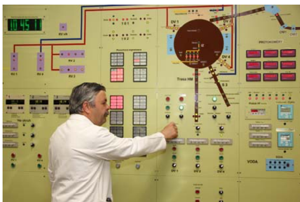
Obr. 3. Nový ovládací a zobrazovací panel podsystémů cyklotronu.
