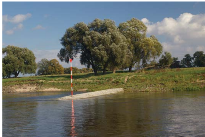
Foto 3. Ukázka koncentračního výhonu v německém úseku řeky Labe
