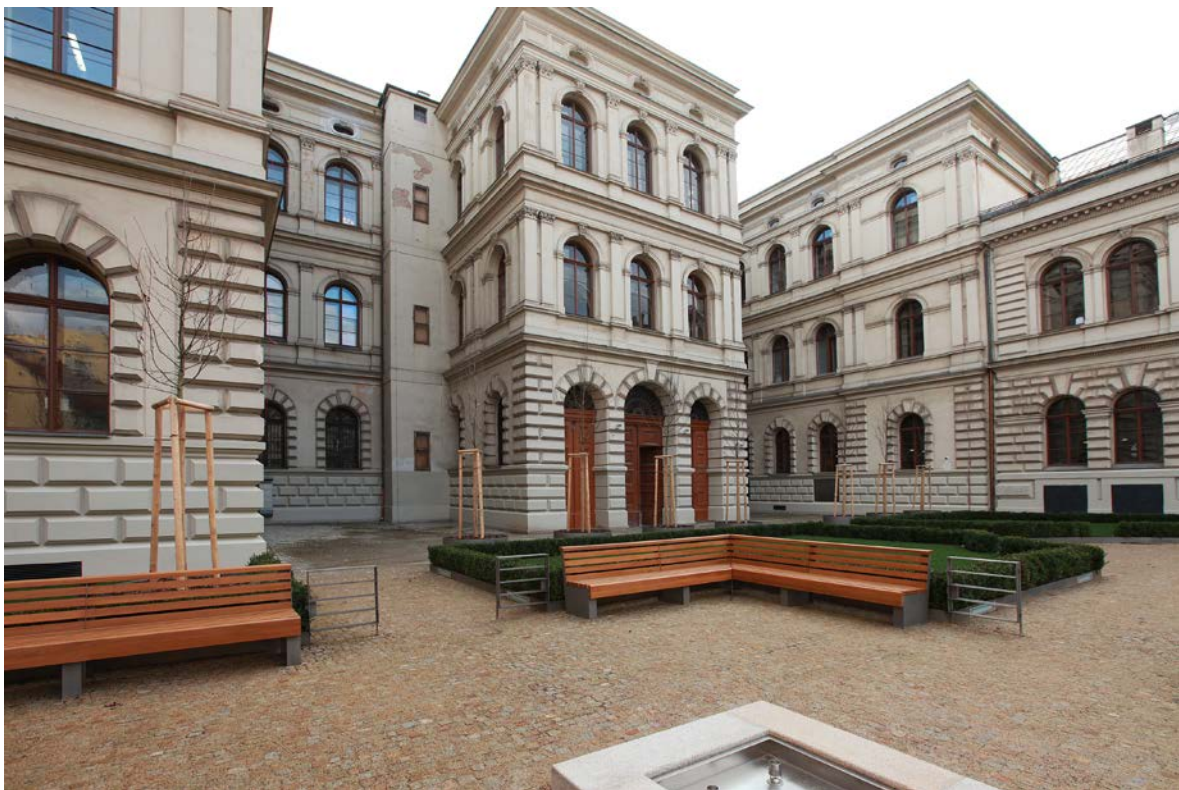
Budova AV ČR
