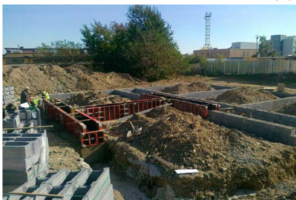
Stavba ubytovny U2 v Krči – začátek
