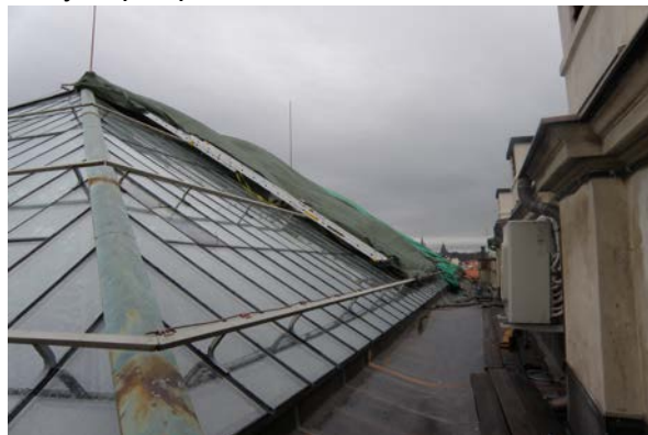
Oprava světlíku po výbuchu plynu
