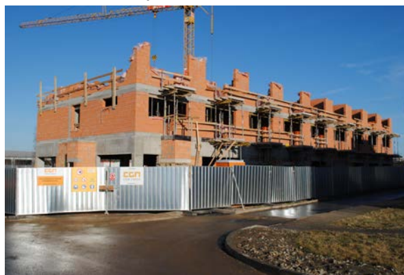
Stavba ubytovny U2 v Krči – průběh
