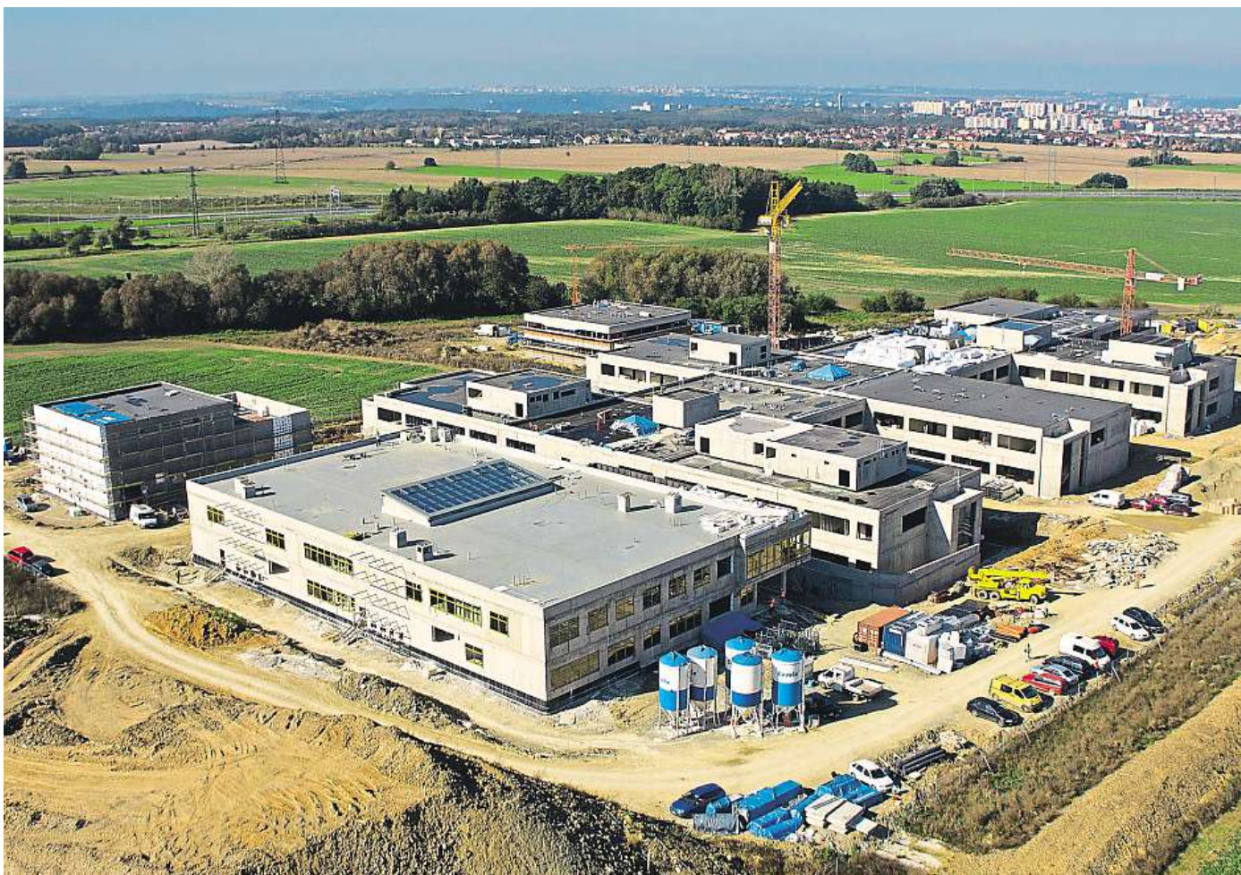
Supercentrum. V závěru prázdnin byla ve Vestci dokončena hrubá stavba výzkumného centra. Nyní začíná montáž technologií.
