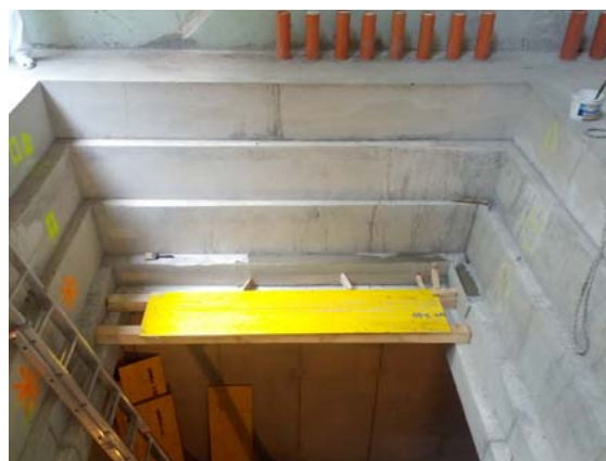
Odstupňovaný průchod ve stropě cyklotronové haly pro instalaci cyklotronu TR 24.
