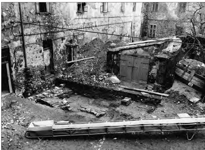
Obr. 12. Most, vnitřní dvůr kláštera minoritů na jaře 1972, pohledy z jižního křídla barokní klausury. Zachycena sonda 2 s úsekem čedičové dlažby a počátek skřívky v sondě 3, která odhalila část refektáře středověké klausury. Foto V. Jílková.
