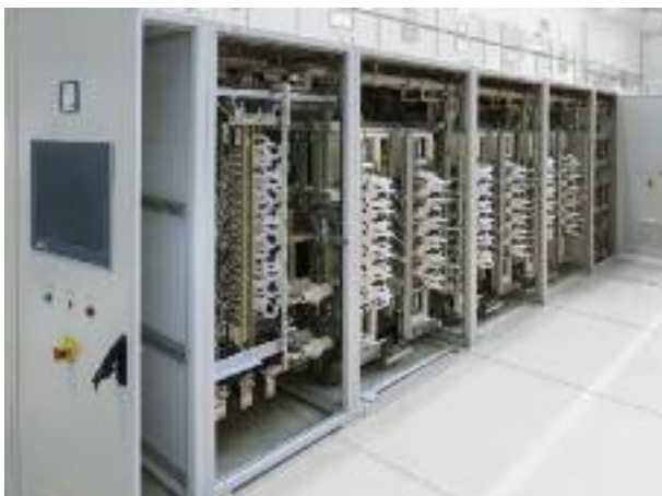
Vnitřní uspořádání měniče (zleva: skříň regulace, následují skříně usměrňovače, 3 fáze střídače, filtru a kapalinového chlazení)
