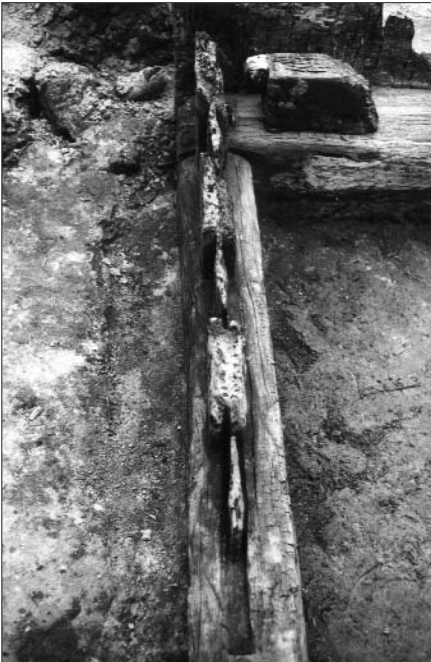
RYC. 9. WROCLAW – UL. IGIELNA 8. BUDYNEK SZKIELETOWY NR 16. PÓŁNOCNA ŚCIANA BUDYNKU ZBUDOWANA Z DESEK ŁĄCZONYCH „NA WPUST TRÓJKĄTNY I WŁASNE PIÓRO”. WG J. PIEKALSKIEGO 1995, FOT. 3.
