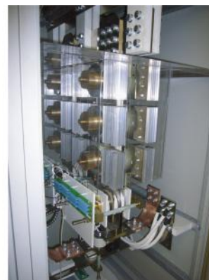
Obr. 9: Detailní pohled dovnitř proudového měniče (vlevo), na tyristory (uprostřed) a na OH system (vpravo).
