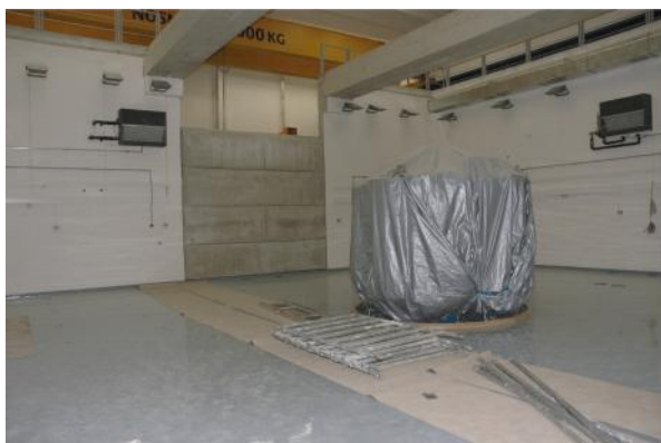
Obr. 5: Hala tokamaku – první patro. Tokamak je instalován a skryt pod plachtou
