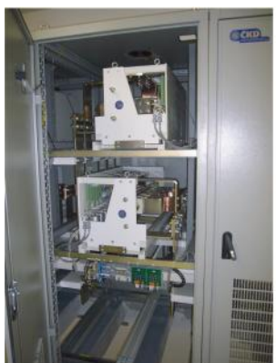
Obr. 9: Detailní pohled dovnitř proudového měniče (vlevo), na tyristory (uprostřed) a na OH system (vpravo).
