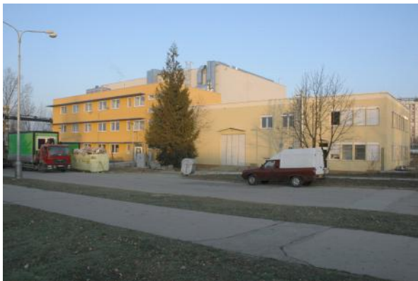
Obr. 1: Budova tokamaku - jižní pohled.
