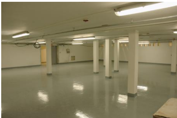
Obr. 3: Hala tokamaku - suterén.
