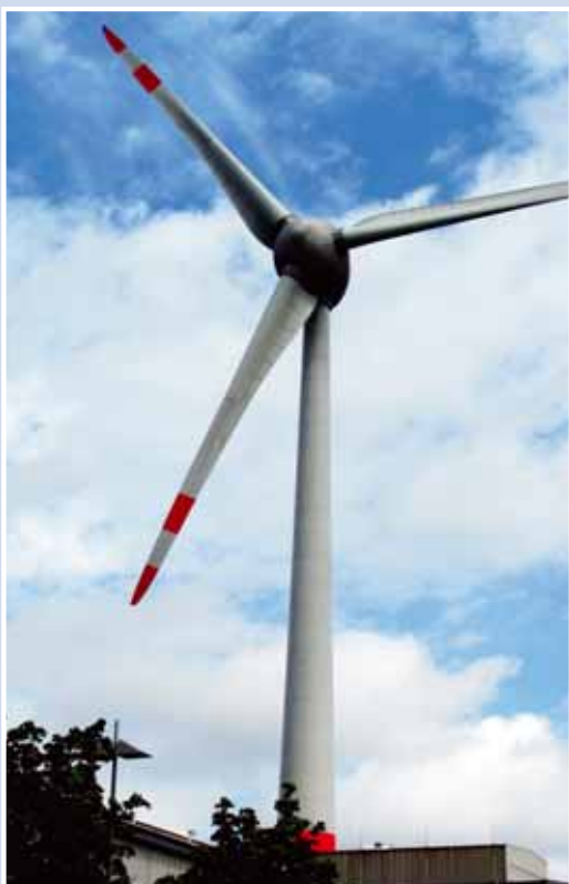
Větrná elektrárna Enercon E-126
