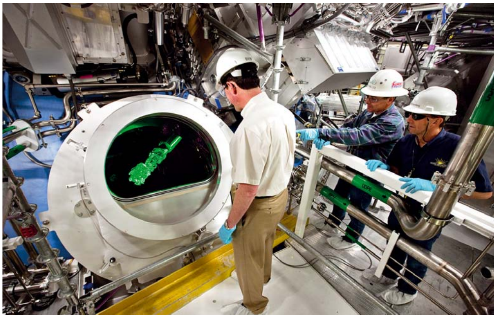
Laser NIF – nové okno (r. 2011) instalované do experimentální komory umožňující pozorovat terč ve vakuu. Na snímku členové NIF týmu Bruno Van Wonterghem (vlevo), Jim Nally (ukazující) and Rod Saunders (vpravo).
