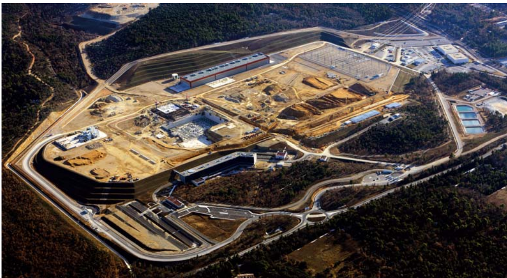
Celkový pohled na staveniště tokamaku ITER. Dobře je vidět sesimistická jáma s kruhovým vzorkem podstavců pro tokamakový komplex, za ní v těsné blízkosti je betonová plocha montážní haly, vzadu zkolaudovaná montážní hala cívek poloidálního pole s rozvodnou vpravo. Budova ředitelství je vpředu. Snímek pořízený z ultralehkého letadla ve výšce nad 500 metrů v únoru 2013. © MatthieuCOLIN.com / ITER Organization
