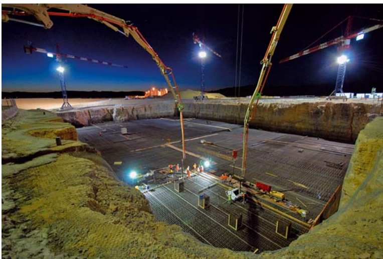
Pokládání betonové desky do antiseismické jámy pro reaktor ITER.
