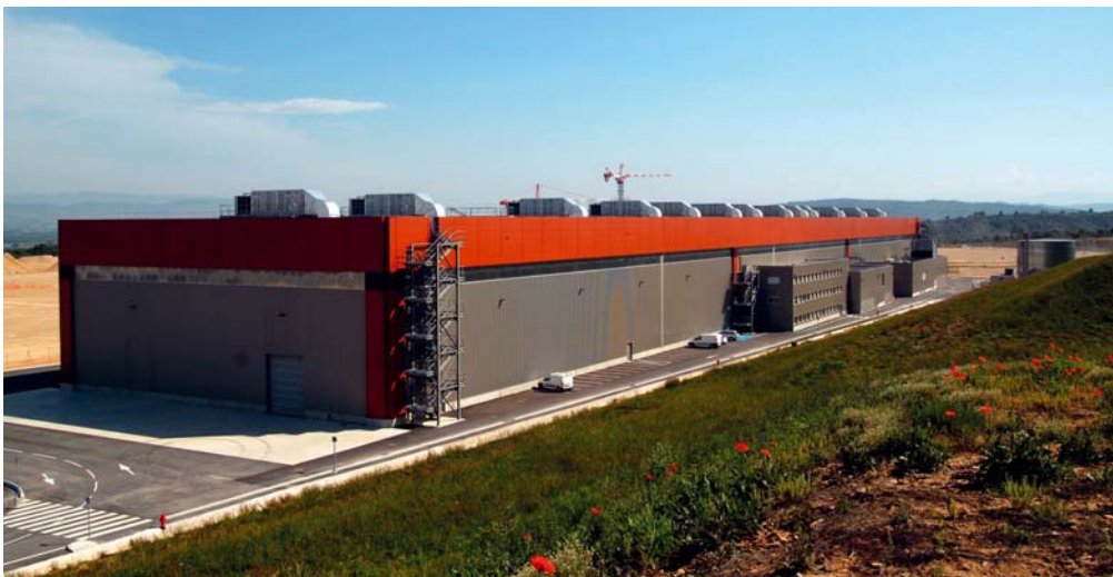
Supravodivé cívký poloidálního magnetického pole (PFCs) pro jejich velikost nelze transportovat – musí se navinout přímo u tokamaku ITER . Na snímku je 257 m dlouhá, 49 m široká a 18 m vysoká hala pro navijení PFCs, Cadarache, Francie.
